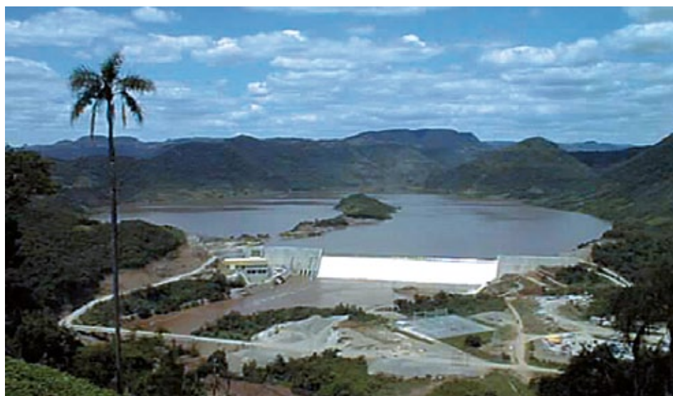
Vista geral do empreendimento | Enterprise Overview
