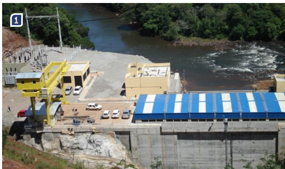
1. Vista externa Casa de Força | External View of the Power House
