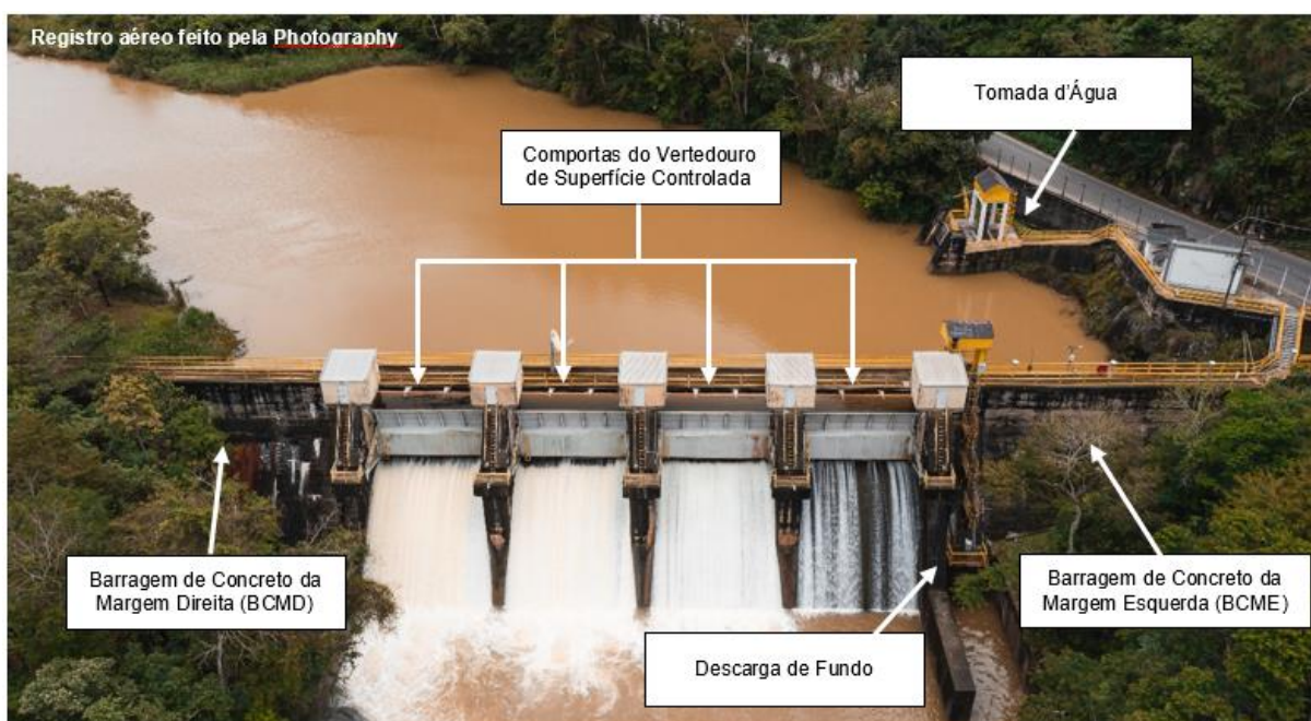
Figura 3 - Arranjo geral do barramento.
