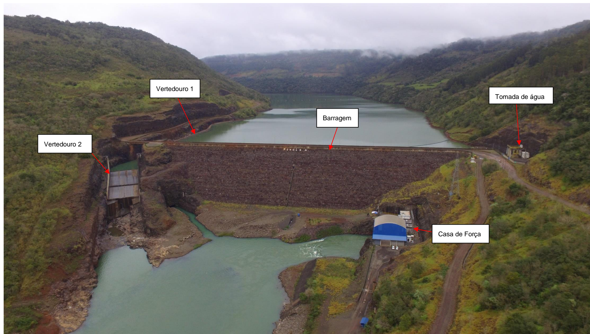
Figura 7 – Foto das estruturas civis – UHE Monjolinho
