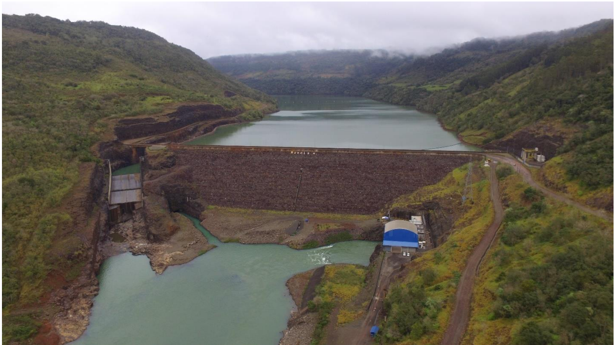
Figura 16 – Vista Geral da Barragem
