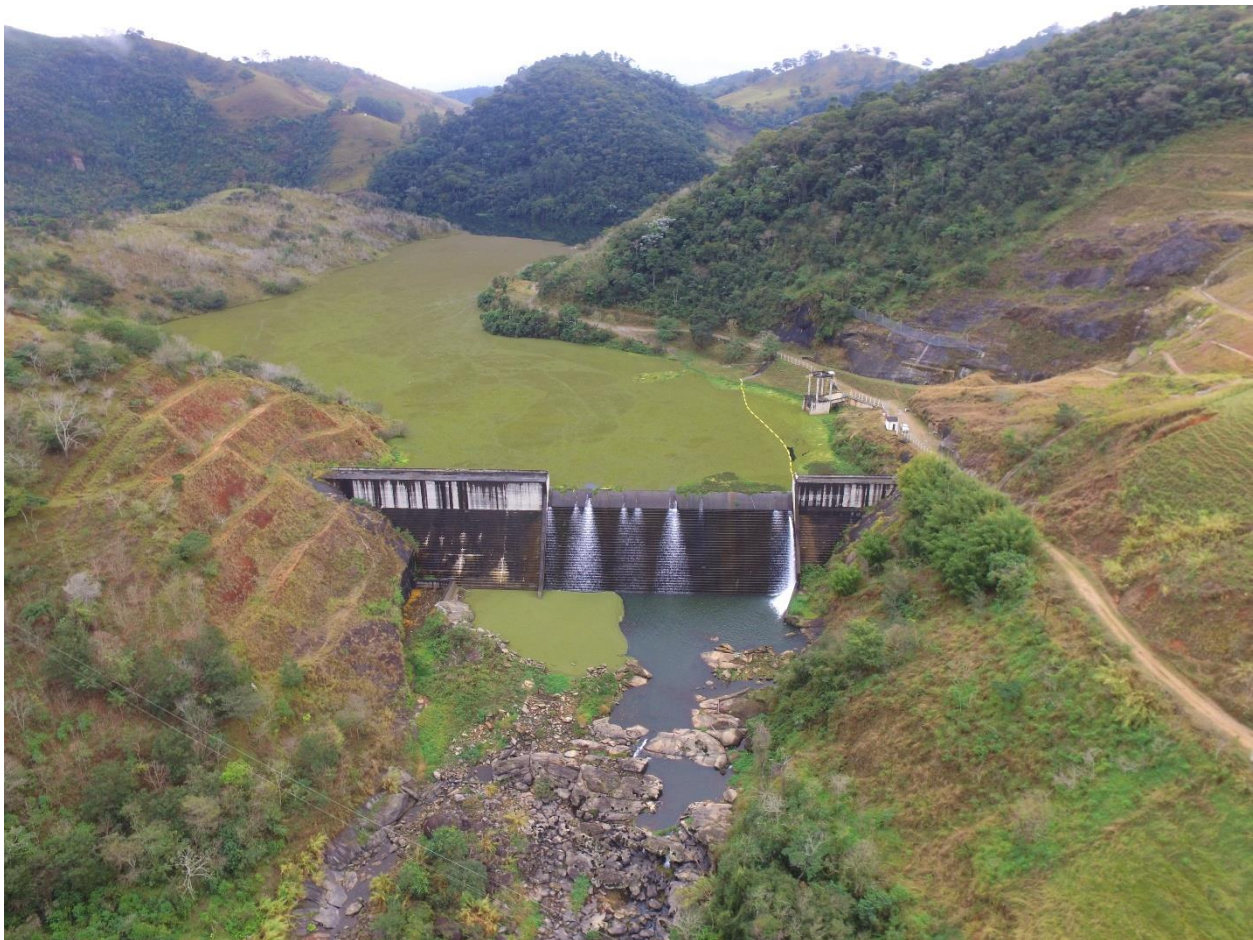
Figura 10 – Vista Geral do Vertedouro
