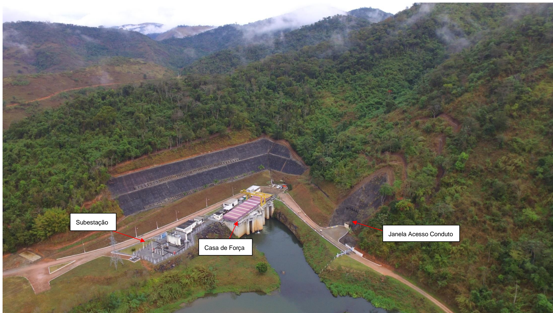
Figura 4 – Foto das estruturas civis Jusante – PCH Santa Rosa II
