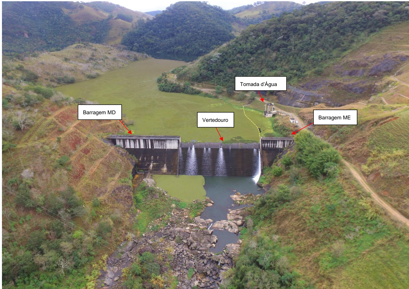
Figura 3 – Foto das estruturas civis Montante – PCH Santa Rosa II
