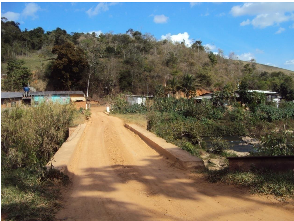
Figura 36 – Ponte de jusante e propriedades
