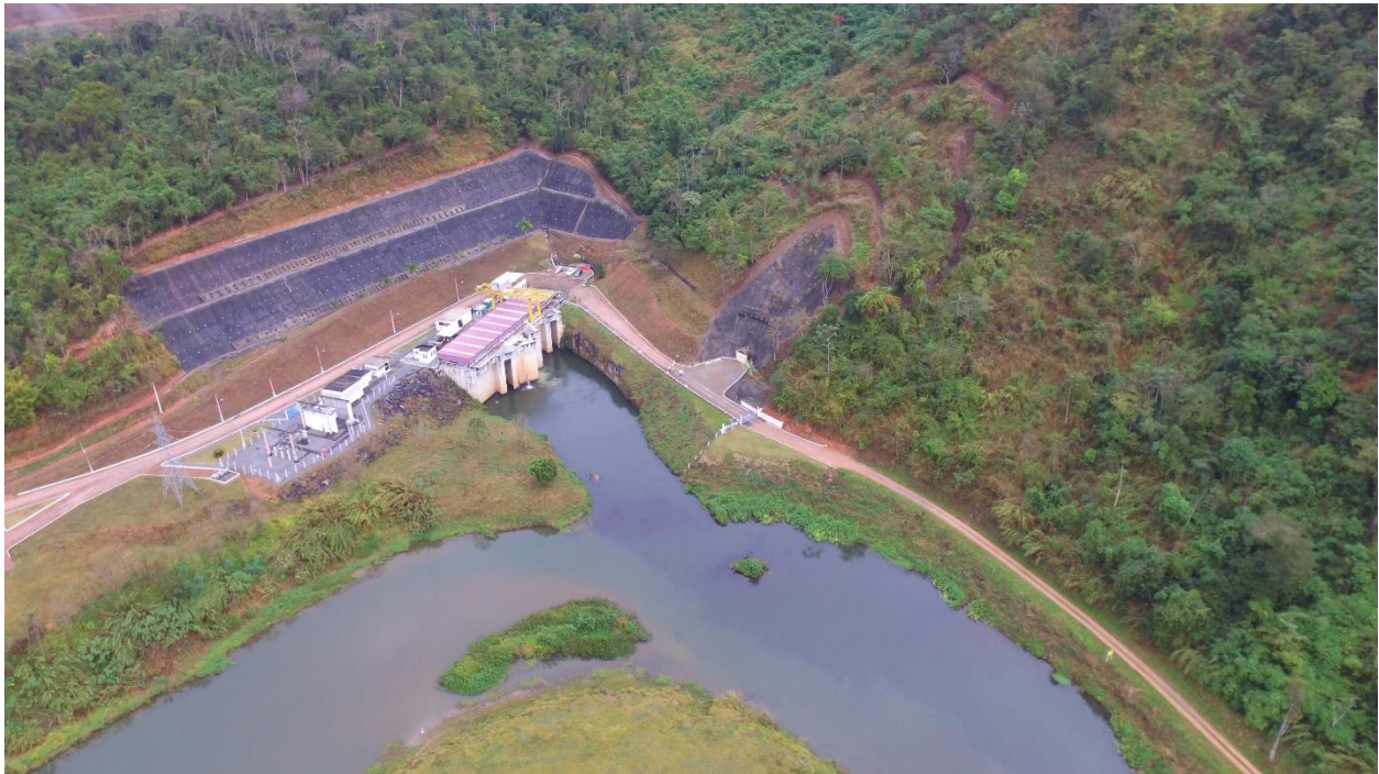
Figura 33 – Casa de Força da PCH Santa Rosa II
