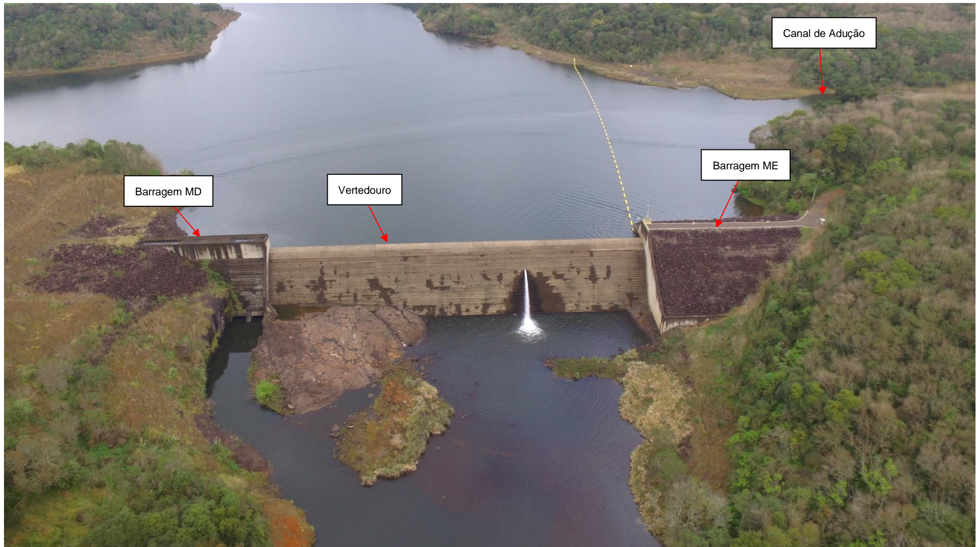
Figura 4 – Foto das estruturas civis do Barramento– PCH Santa Laura
