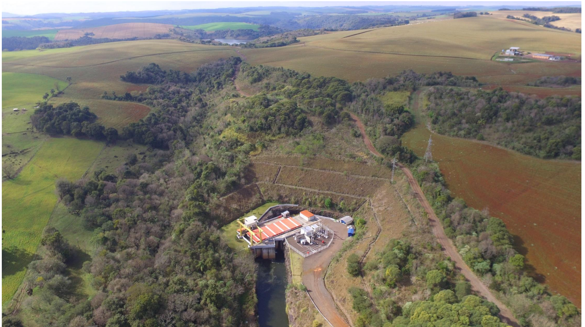
Figura 6 – Vista Geral Jusante– PCH Santa Laura
