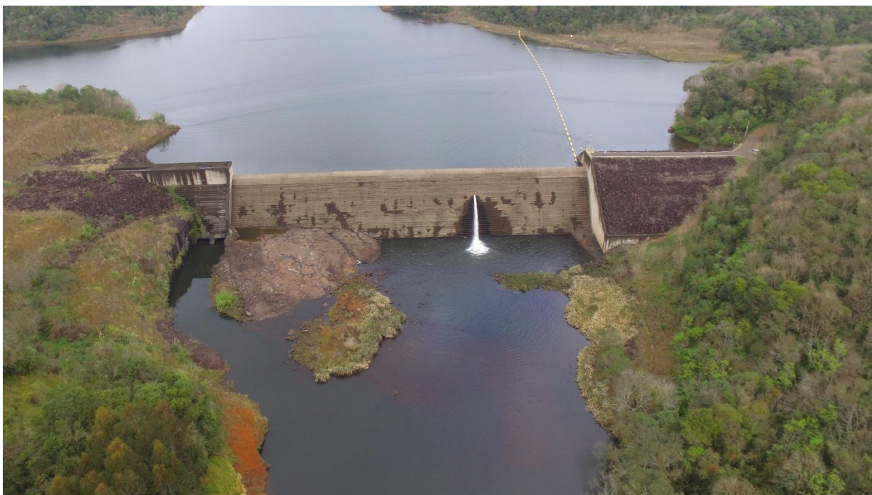
Figura 11 – Vista Geral do Barramento
