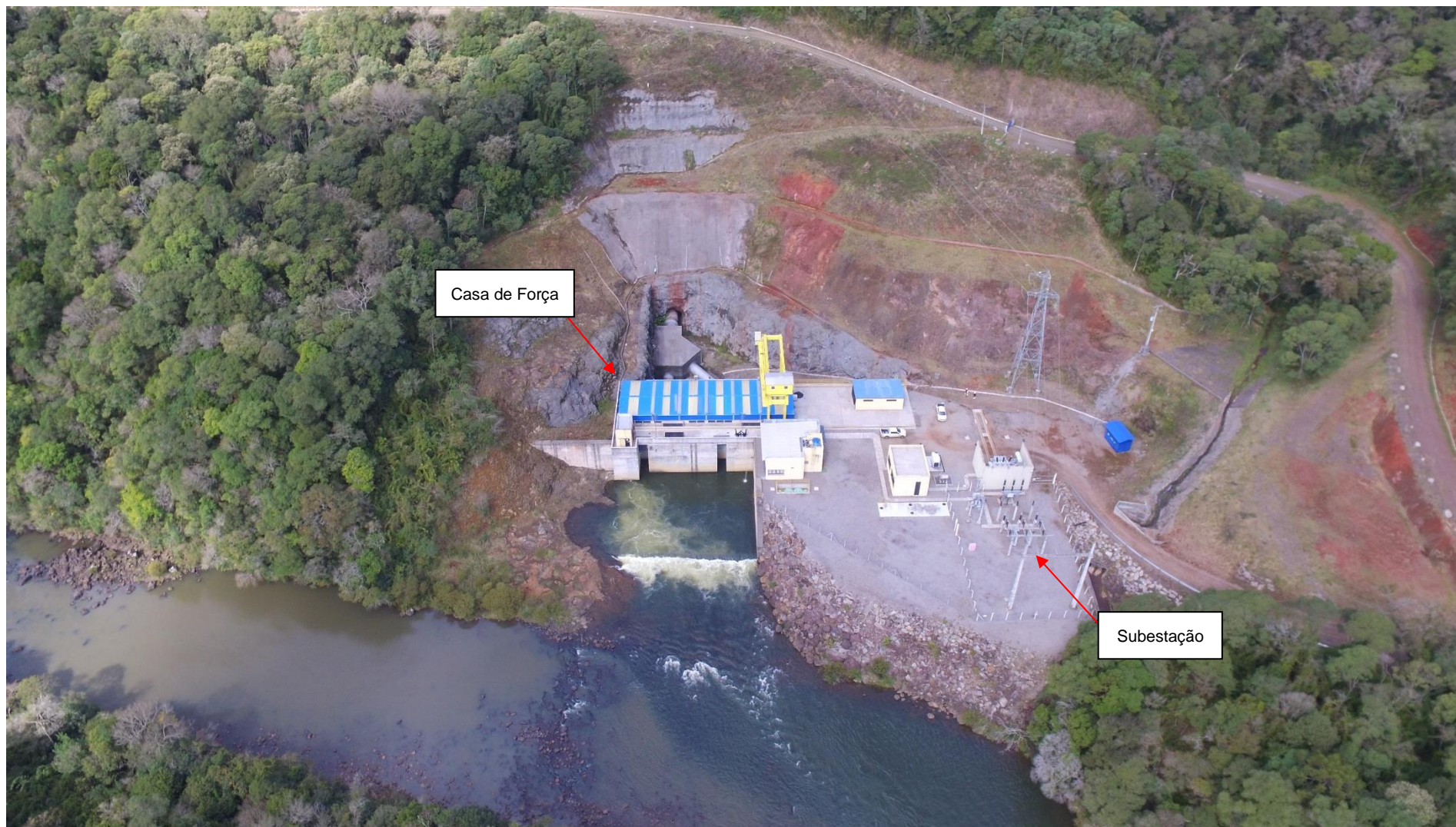
Figura 6 – Vista Geral Jusante – PCH Victor Baptista Adami
