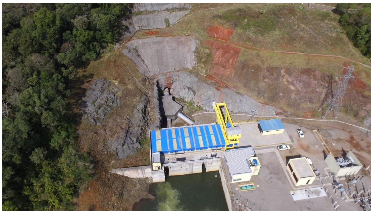
Figura 35 – Casa de Força da PCH Victor Baptista Adami
