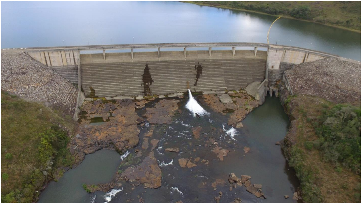
Figura 18 – Vista Geral do Barramento
