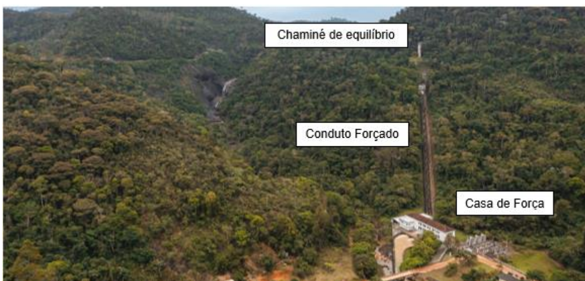
Figura 3 - Vista da chaminé de equilíbrio, conduto e casa de força.
