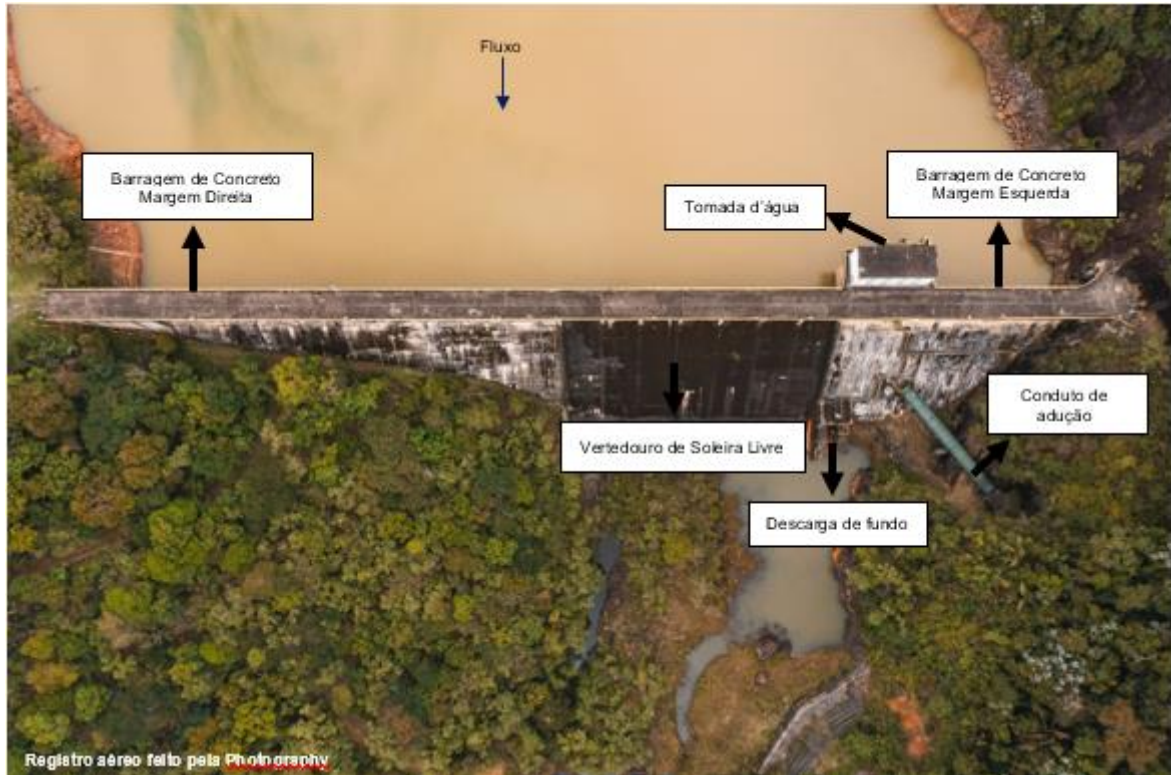
Figura 4 - Arranjo geral do barramento.
