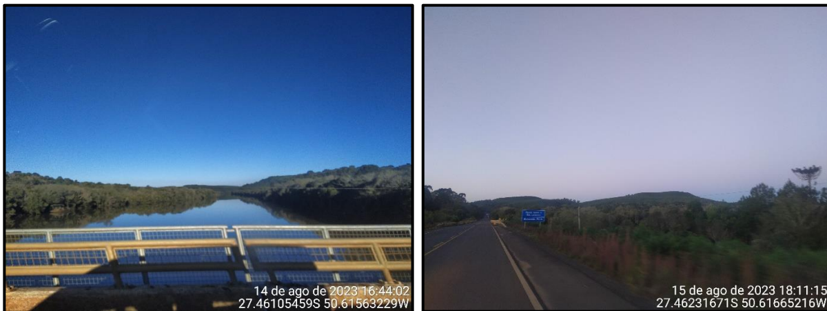
Figura 364 - Ponte sobre o rio Canoas e respectiva sinalização na rodovia SC-120.
