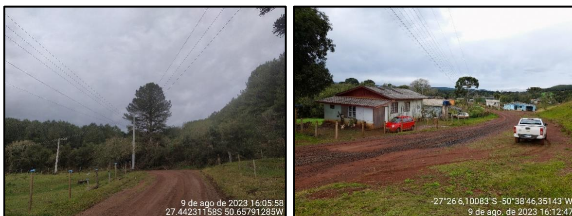
Figura 363 – Estrada Geral - distrito de Santa Cruz do Pery.
