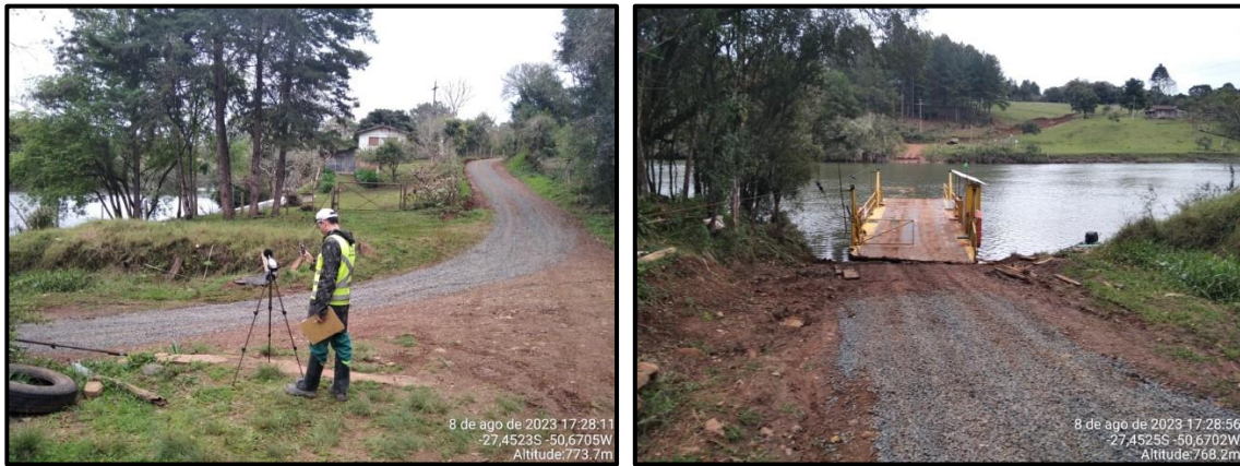
Figura 121 - Vista geral do ponto 02.
