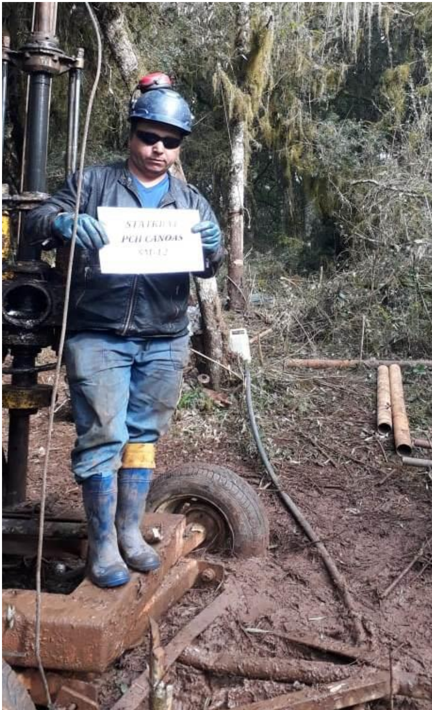
Figura 5. Registro fotográfico da execução da sondagem SM-12.
