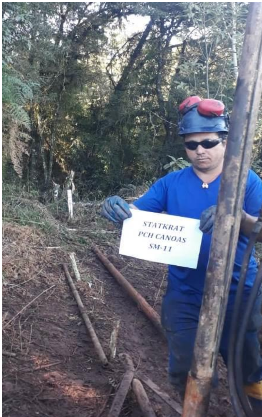
Figura 3. Registro fotográfico da execução da sondagem SM-01 em campo.
