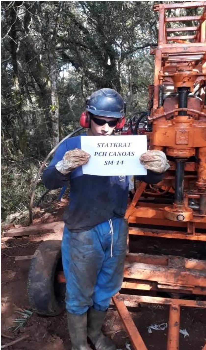
Figura 16. Registro fotográfico da execução da sondagem SM-14.
