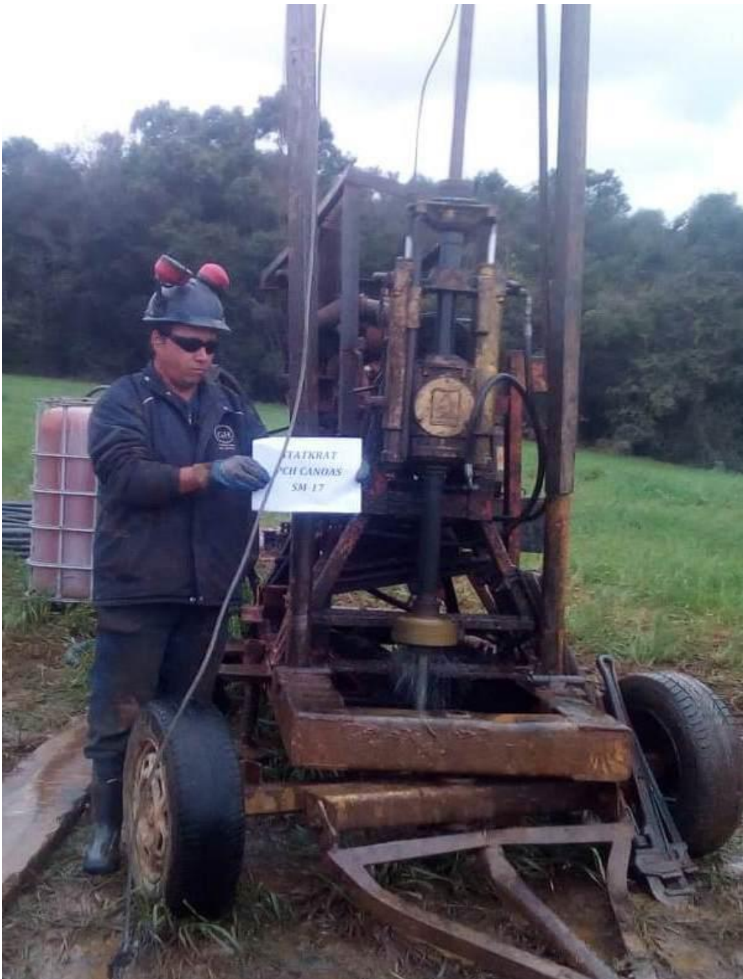
Figura 26. Registro fotográfico da execução da sondagem SM-17.
