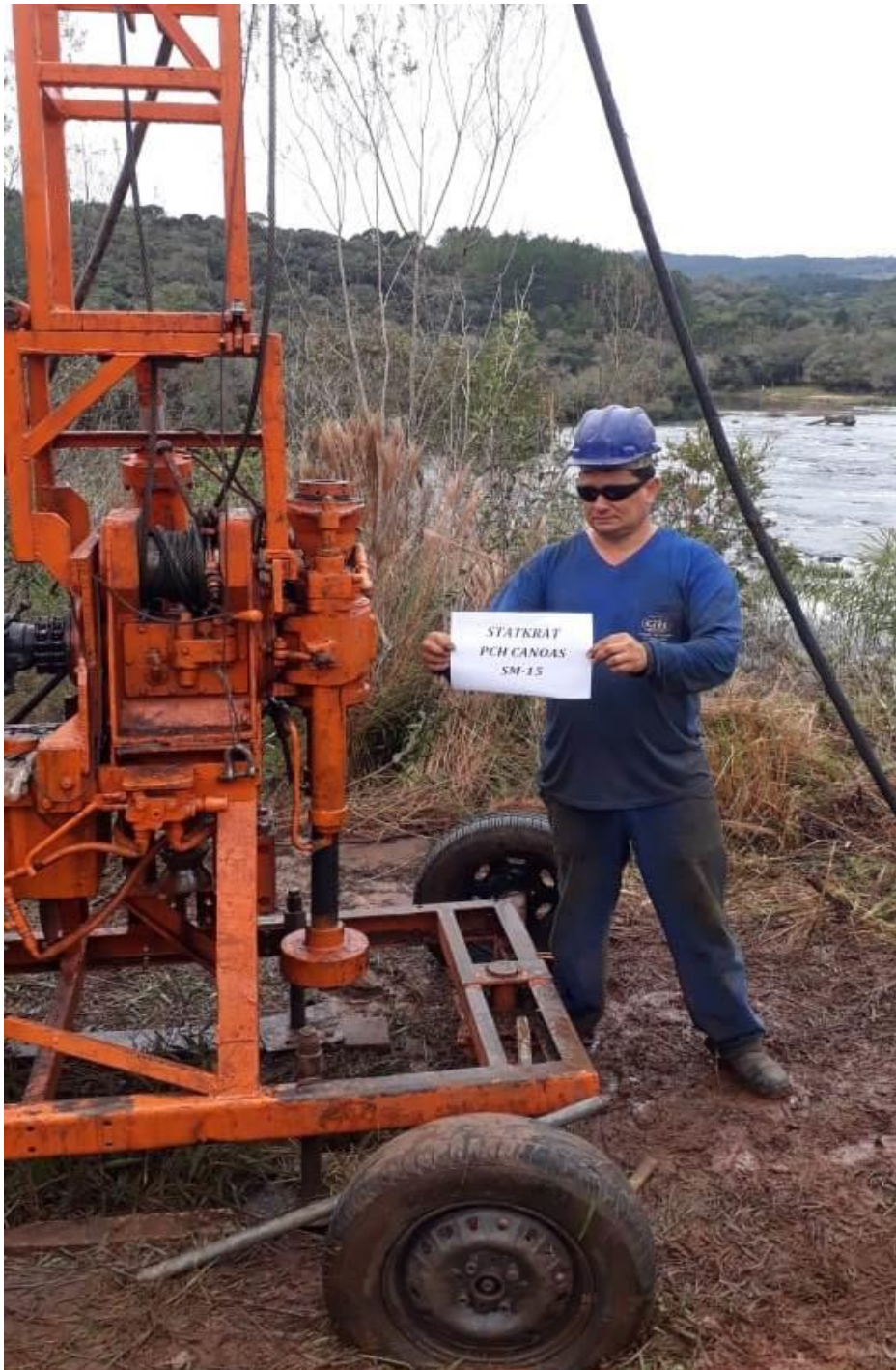
Figura 22. Registro fotográfico da execução da sondagem SM-15.
