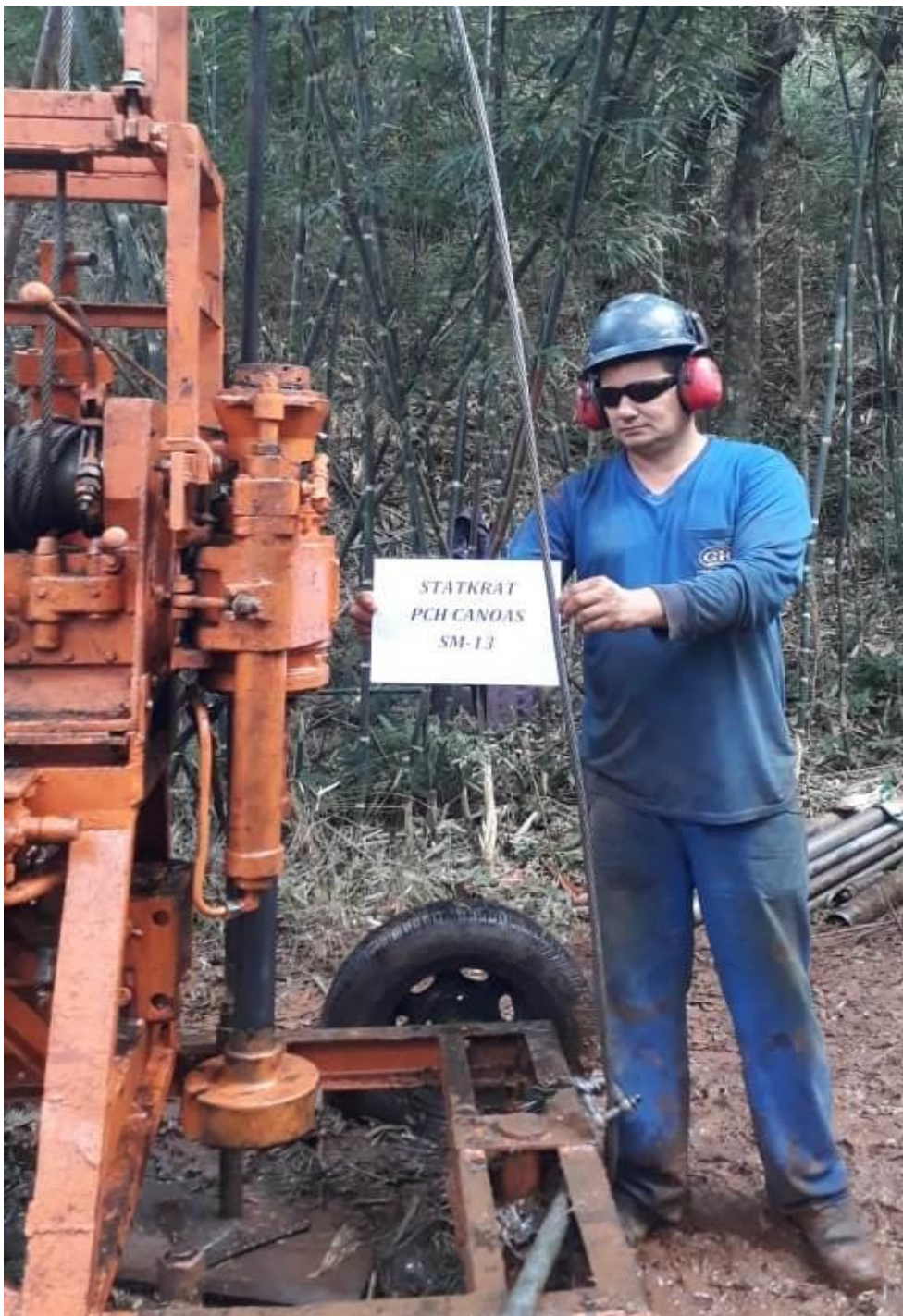
Figura 11. Registro fotográfico da execução da sondagem SM-13.
