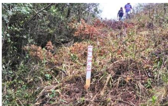
Figura 10 – Execução do CE-13 na margem esquerda
