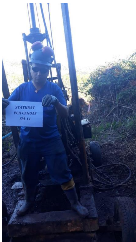
Figura 16 – Execução da SM-11 margem esquerda em 28/07/18
