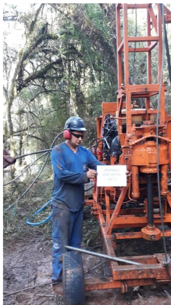
Figura 17 – Execução da SM-13 margem esquerda. Período de 28 a 29/07/18
