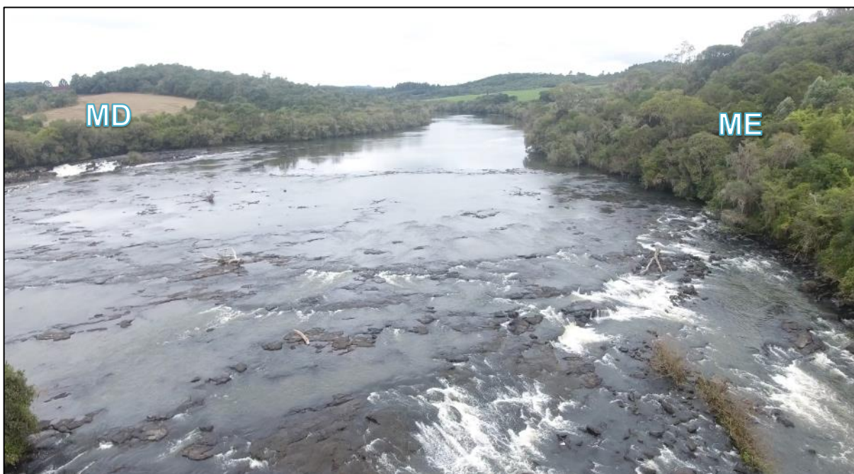
Figura 100 – Platô de montante da corredeira – Vista de jusante
