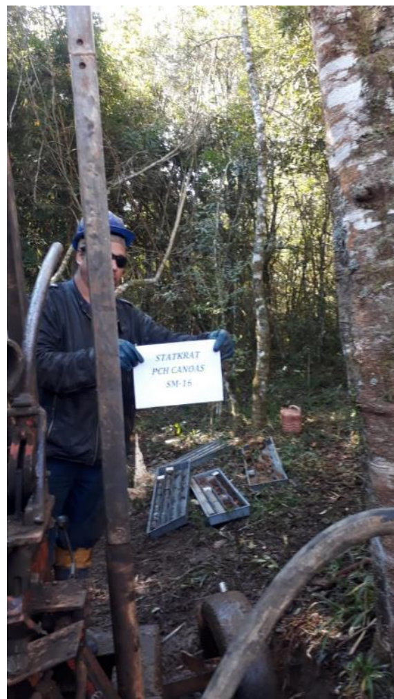
Figura 19 – Execução da SM-16 margem direita em 31/07/18 Fonte: GH Sondagens
