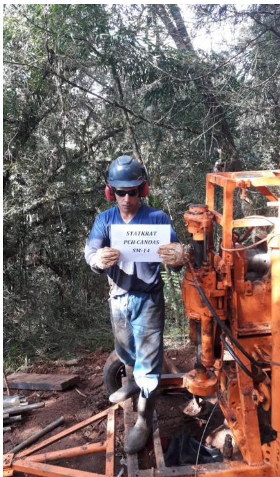
Figura 14 – Execução da SM-14 margem esquerda.
