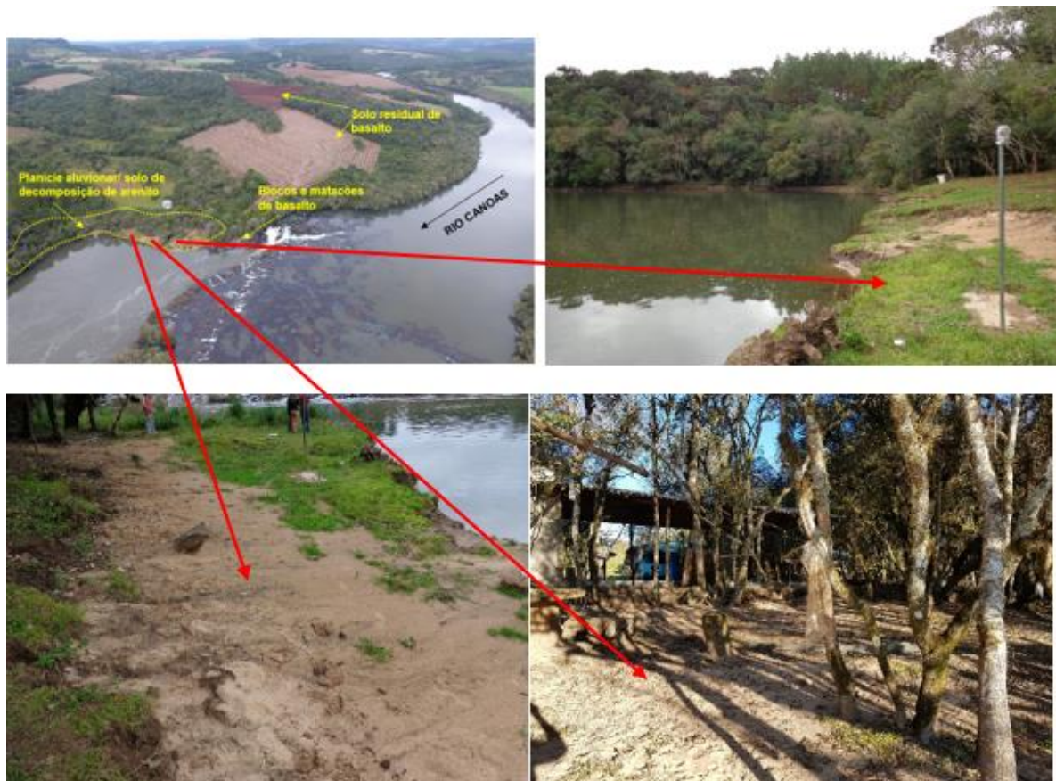
Figura 49– Foto da margem direita no local em estudo. Em destaque a planície aluvionar/solo arenoso, blocos e matacos que ocorrem na margem
