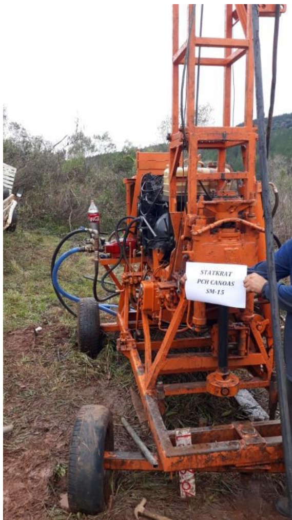
Figura 18 – Execução da SM-15 margem esquerda. Período de 30 a 31/07/18 Fonte: GH Sondagens
