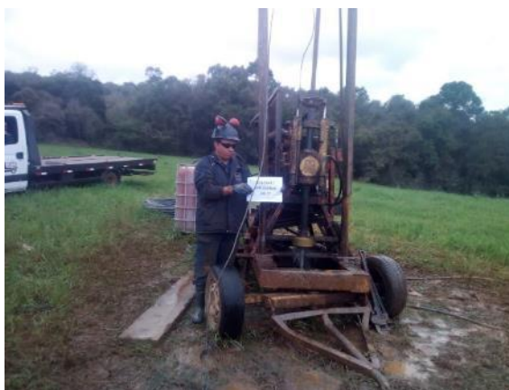
Figura 20 – Execução da SM-17 margem direita. Período de 31/07 a 02/08/18 Fonte: GH Sondagens
