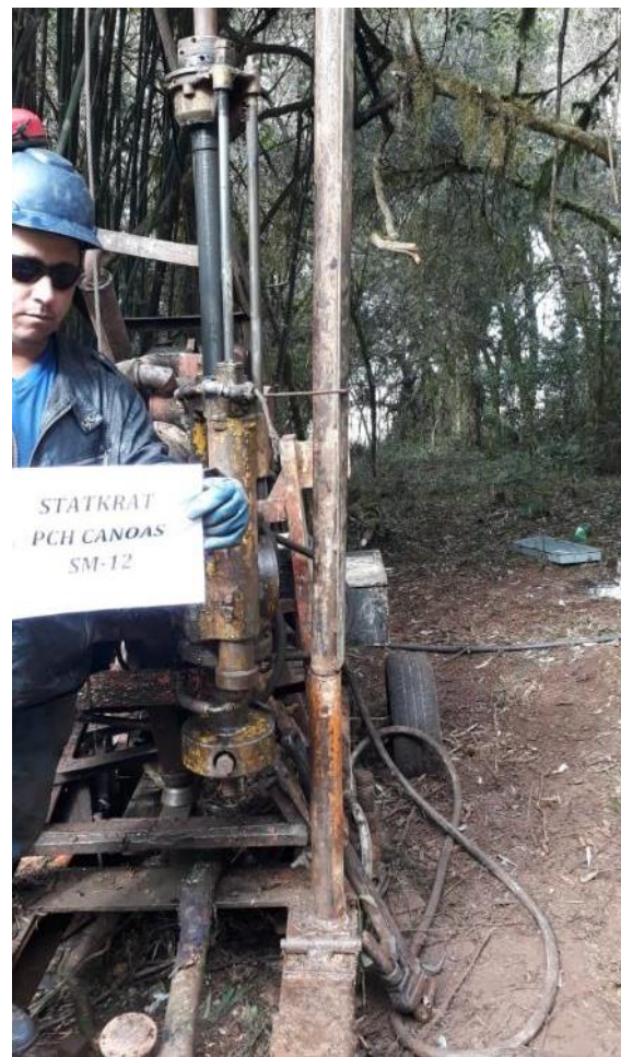
Figura 15 – Execução da SM-12 margem esquerda.
