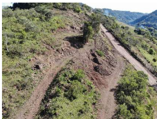
Foto 47 – Local de retirada de material rochoso (cascalho) da Área 3.
