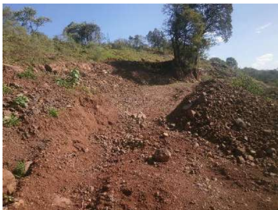
Foto 48 – Local de retirada de material rochoso (cascalho) da Área 3.
