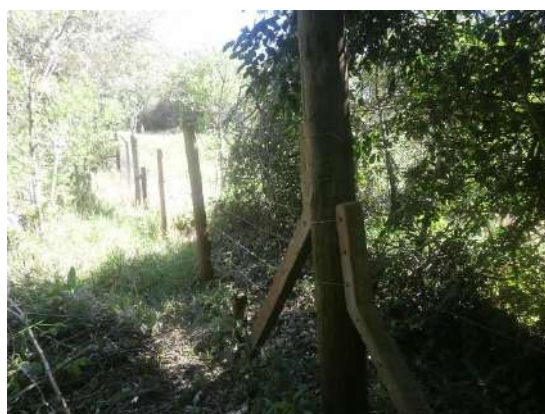
Foto 33 – Cercamento no entorno da Área 1 em boas condições.
