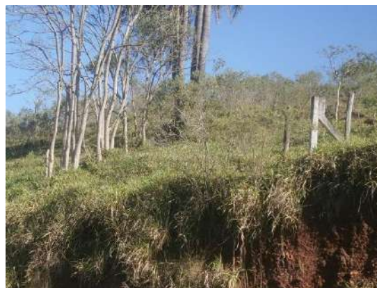
Foto 49 – Cercamento danificado na Área 3.
