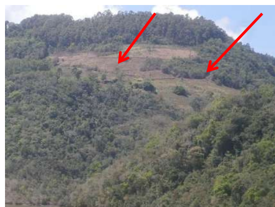
Foto 18 – Estrutura na APP e registro de queimada da vegetação verificada na campanha de fevereiro de 2022 sem alteração no ponto P18.
