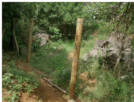
Foto 30 – Conserto do cercamento no local preferencial de entrada do gado na área de recuperação (Coordenadas geográficas SIRGAS 2000 -27.335980°/-52.731760°).
