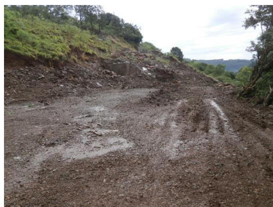
Foto 44 – Local de retirada de material rochoso (cascalho) da Área 3.
