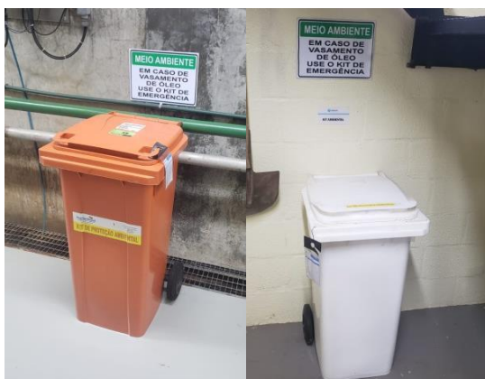
Foto 65 – Kit de mitigação na área interna e no almoxarifado.
