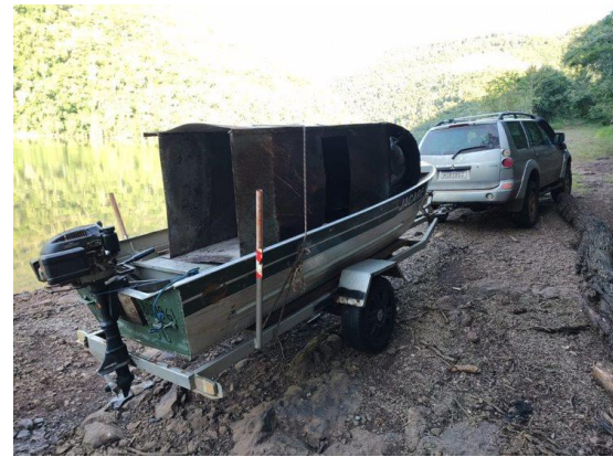
Foto 20 – Retirada das estruturas no P13.
