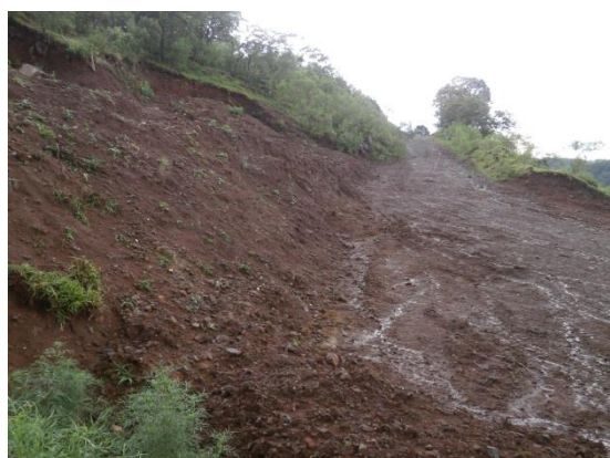
Foto 43 – Acesso utilizado para retirada de cascalho e cercamento inexistente em vários trechos da Área 3.
