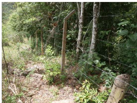
Foto 29 – Cercamento consertado no entorno da Área 1 limite com o acesso municipal.
