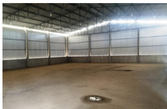
Foto 18 - Galpão garagem concluído.
