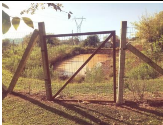
Foto 4 - Açude da Sede T.I Votouro Guarani, quase vazio devido a estiagem em vistoria realizada em maio de 2020.
