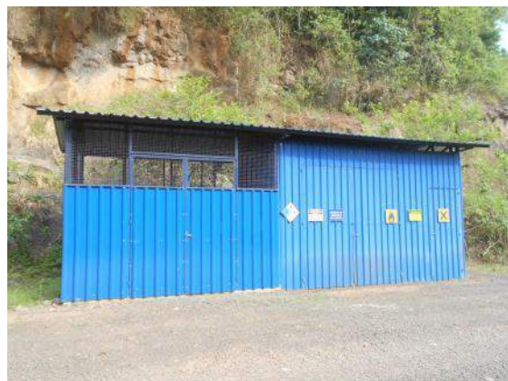
Foto 41 – Depósito para resíduos e materiais perigosos devidamente identificado.
