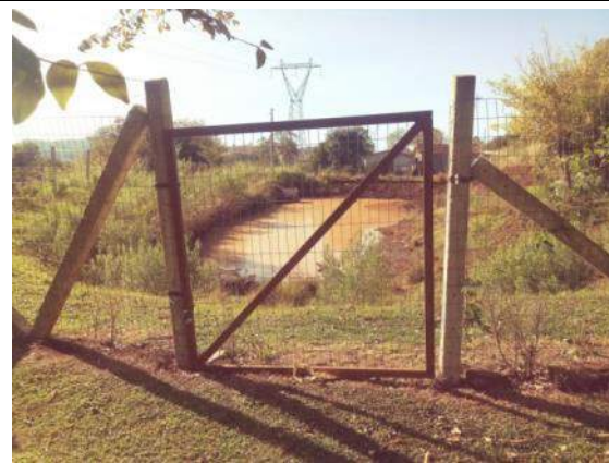
Foto 4 - Açude da Sede T.I Votouro Guarani, quase vazio devido a estiagem em vistoria realizada em maio de 2020.
