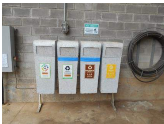
Foto 43 – Coletores identificados na área externa da Casa de Força.
