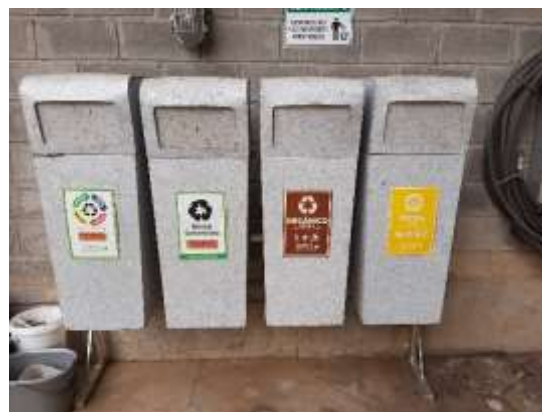
Foto 60 – Coletores identificados na área externa da Casa de Força.
