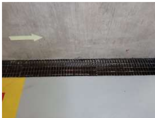
Foto 68 – Canaleta na área das UG's.
