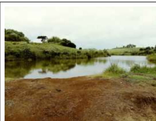
Foto 23 - Açude denominado Campininha (TI Kaingang) sem problemas aparentes.
