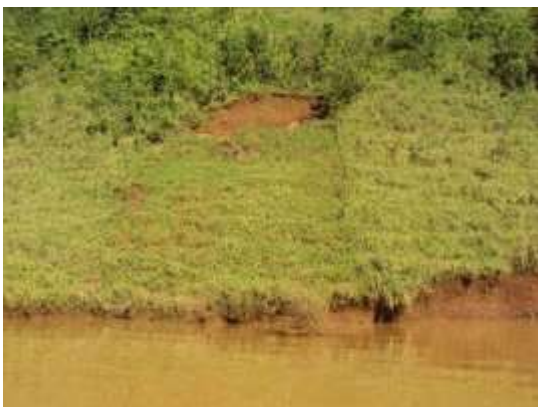
Foto 3 - Situação inicial da instabilidade no Ponto 11. Vistoria realizada em 21/07/11.
