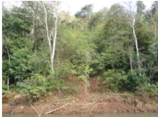
Foto 8 - Situação atual no Ponto 20. Vistoria realizada em 08/08/17.
