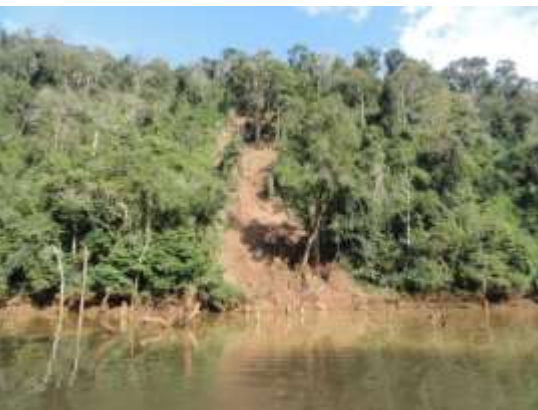
Foto 11 – Vista geral do novo local com processo erosivo na margem esquerda do reservatório. Ponto 24. Vistoria realizada em 08/08/17.
