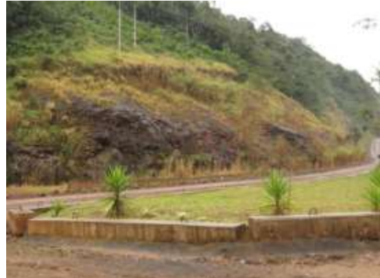
Foto 2 - Situação atual no Ponto 10. Vistoria realizada em 08/08/2017.
