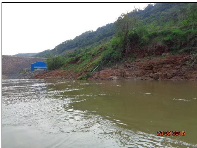
Figura 6. Vista parcial do ponto localizado no rio Passo Fundo, a jusante e próximo à barragem, área diretamente afetada da UHE Alzir dos Santos Antunes, Nonoai, RS.
