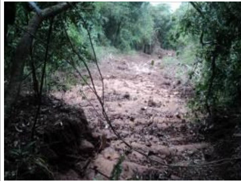
Vistoria realizada em 25/11/13.
