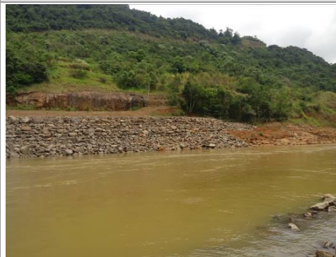
Vistoria realizada em 25/06/15
