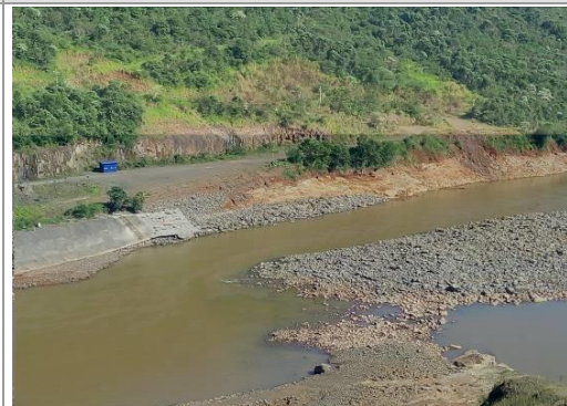
Vistoria realizada em 20/12/15
