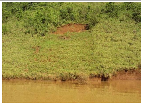
Vistoria realizada em 21/07/11.
