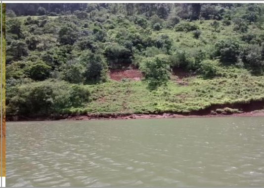
Vistoria realizada em 10/12/15.
