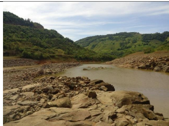
Foto 19 Abertura de canal para passagem da água do vertedouro.
