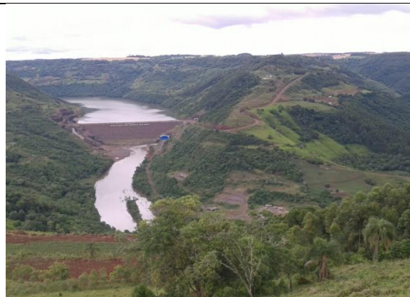
Foto 18 Situação da barra antes dos trabalhos.
