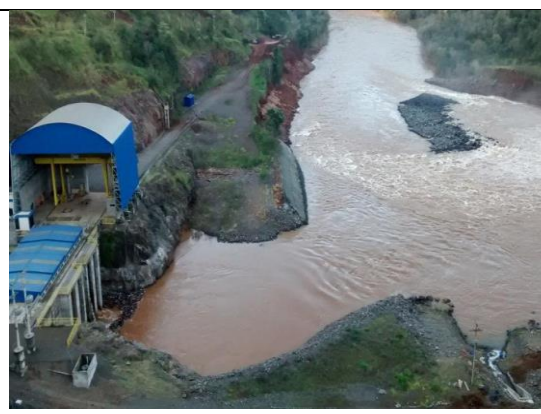
Foto – 10 - Vista da cheia de 28.06.2014 mostrando uma área de aproximadamente 2250m 2 sem qualquer tipo de vegetação. A mata ciliar foi removida por completo por solapamento das margens. Esse local era área de reposição e adensamento florestal da UHE.
