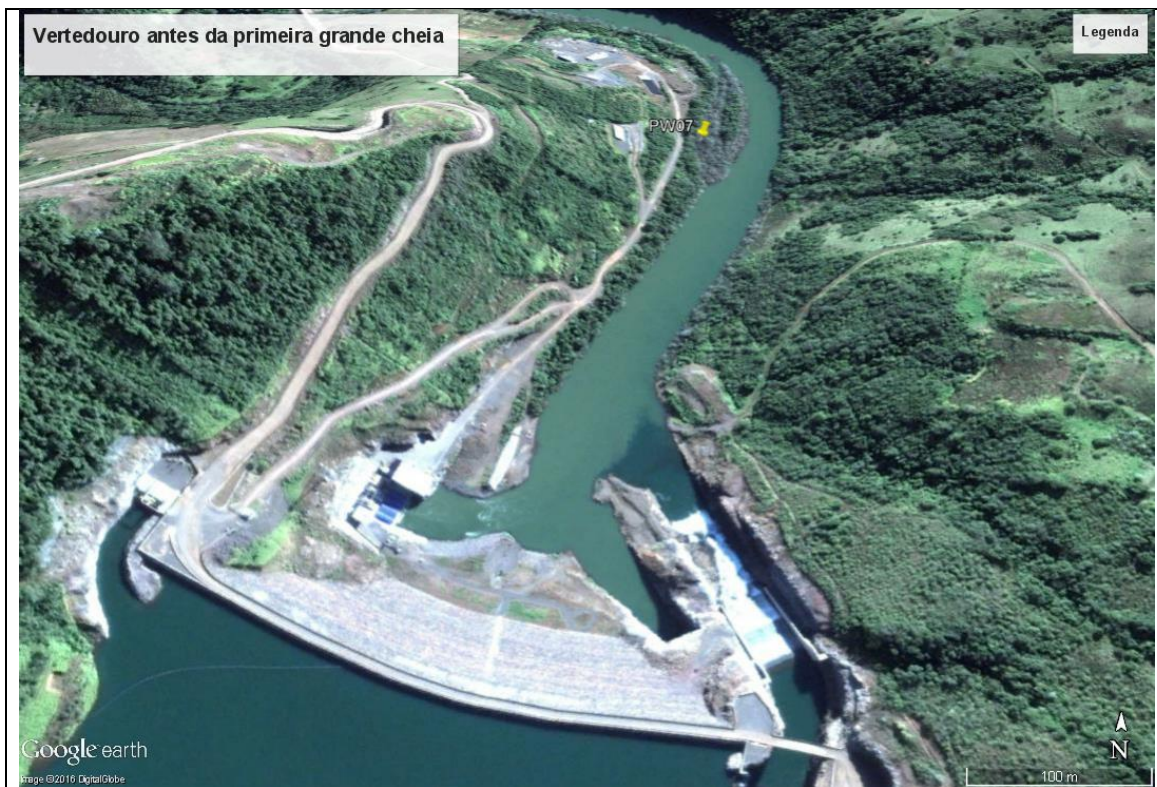
Imagem 1 – Vista original do vertedouro no período de 2010 até agosto de 2011 onde não havia danos no vertedouro, nem material junto ao leito do rio.
