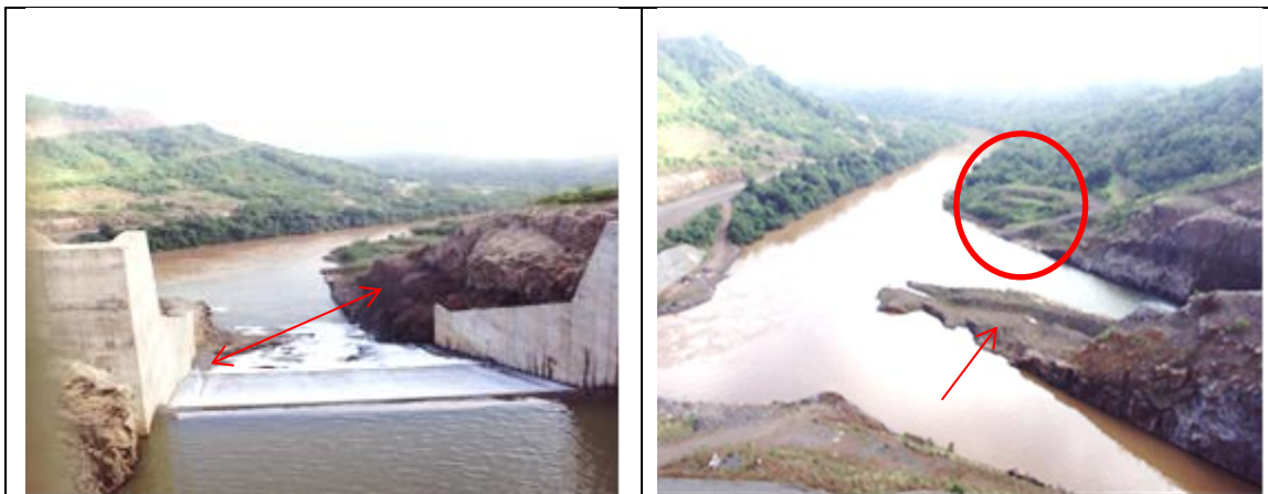
Fotos 01 e 02 Vista do vertedouro e do leito do rio em 2009 até agosto 2011, antes de acontecer um período de grandes vazões. No destaque é possível ver um bota-fora na direita hidráulica que posteriormente foi lançado no leito do rio, em conjunto com o material fragmentado (deslocado) do vertedouro que viria a abarrotar a calha o Passo Fundo, bem como uma berma de material solto na esquerda hidráulica.
