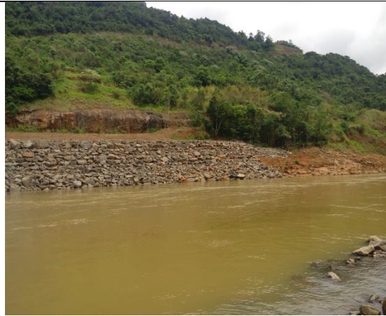
Foto 22 Proteção da margem direita feita com matações retirados do leito do rio 2014.
