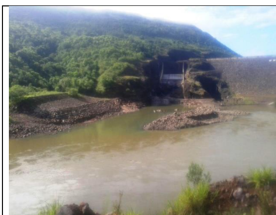
Foto 22 Barra aberta e conformada na frente do vertedouro 2014.
