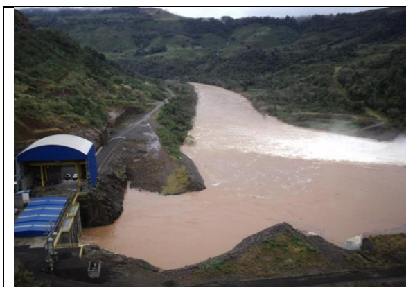
Foto -09 - Vista da cheia de 20.07.2011 até então a maior cheia ocorrida junto ao Rio Passo Fundo desde o início da operação, é possível observar que a mata ciliar praticamente não foi afetada ficando os danos restritos ao acesso a barcos de jusante da usina. Também ocorreu a formação de uma nova barra de rochas em frente ao vertedouro.
