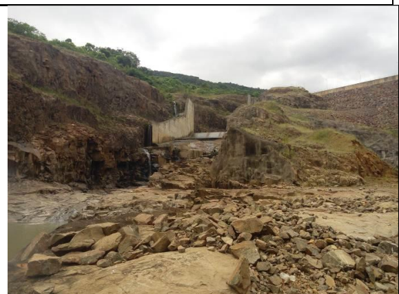
Foto 15 Depósito de rochas do bota-fora
