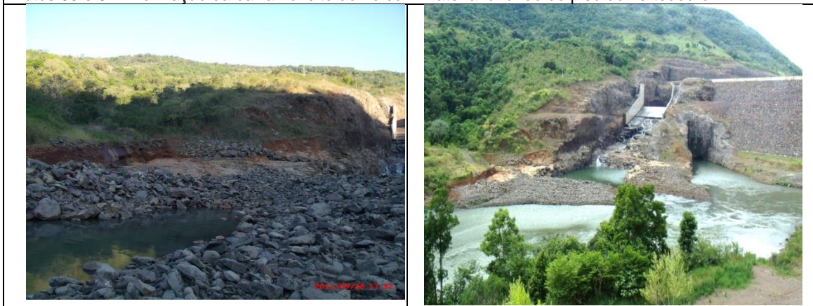
Fotos 05 e 06 - Bota-fora da margem esquerda erodido e lançado na calha do rio, situação atual da configuração do leito e das rochas depositadas.
