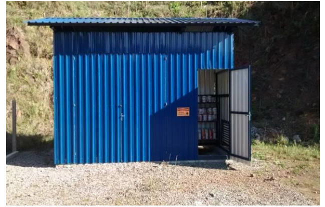
Foto 16: Foto da área externa do depósito de produtos perigosos.
