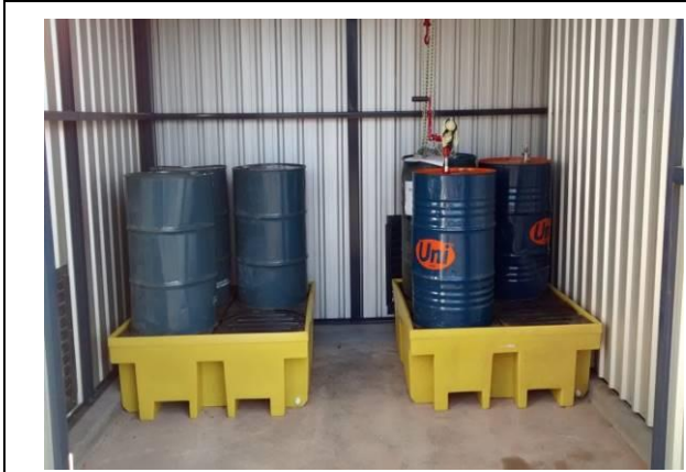
Foto 15: Depósito de óleo e combustível, com armazenamento em pellets.
