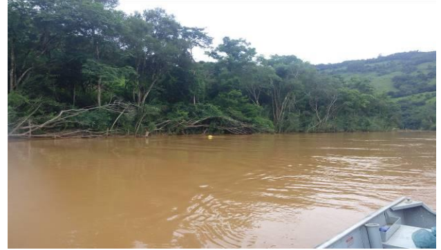
Foto 10: Log Boom de jusante rompido pela cheia.
