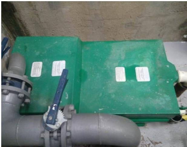
Foto 11: Sistema de separação de água e óleo.
