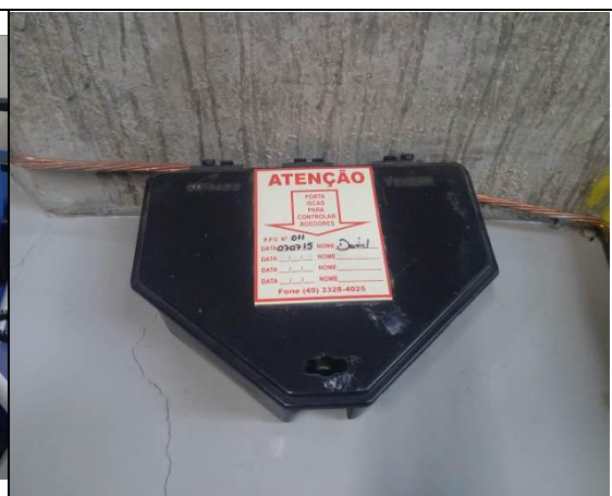
Foto 10: Controle de Roedores na casa de força.
