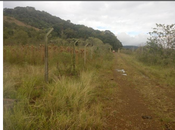
Foto 2 – Continuidade do acesso a subestação somente com os mourões de concreto com
