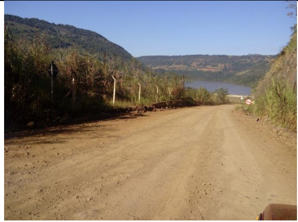
Foto 8 –. Roçada e limpeza e pintura de cal.
