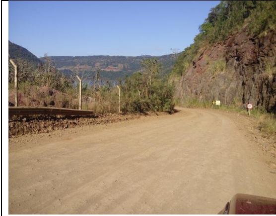
Foto 7 – Cerca de acesso usina roçada e limpeza.
