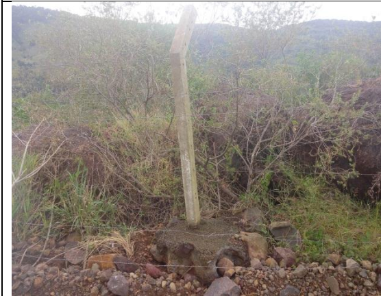
Foto 9 – Local sem arames, com moirão desalinhado.
