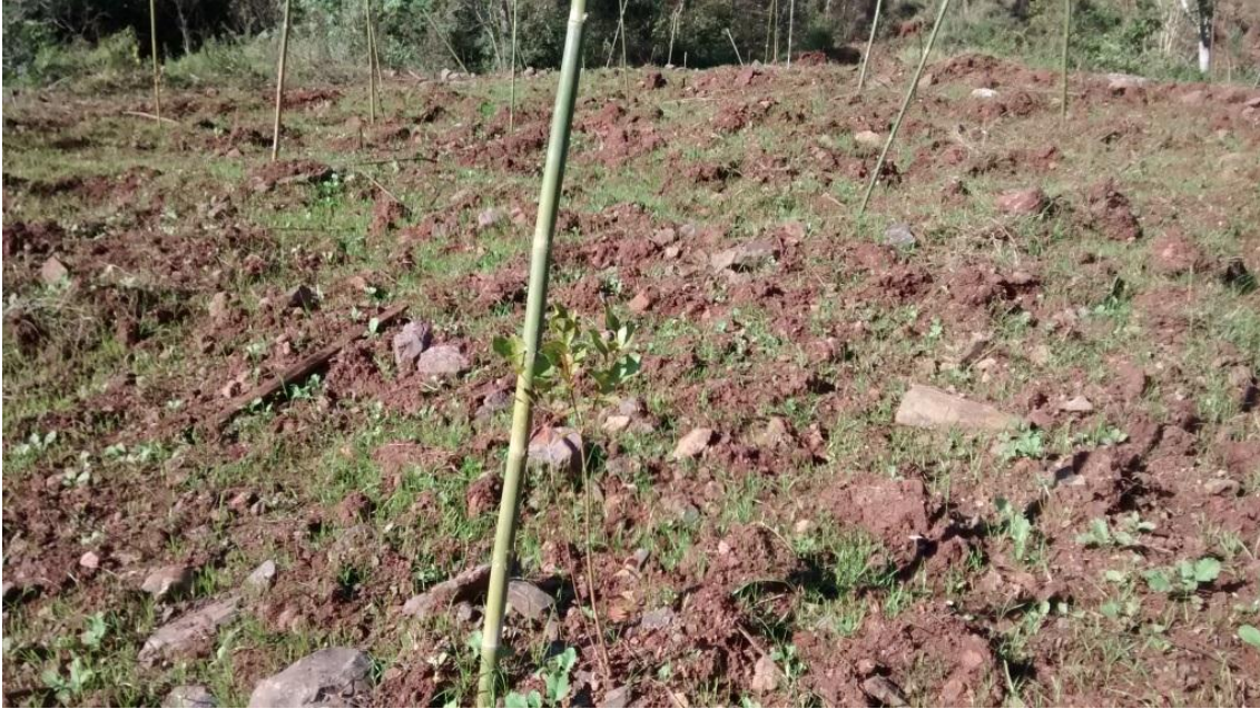
Recuperação do talude da margem direita após a semeadura do azevém e plantio das mudas.
