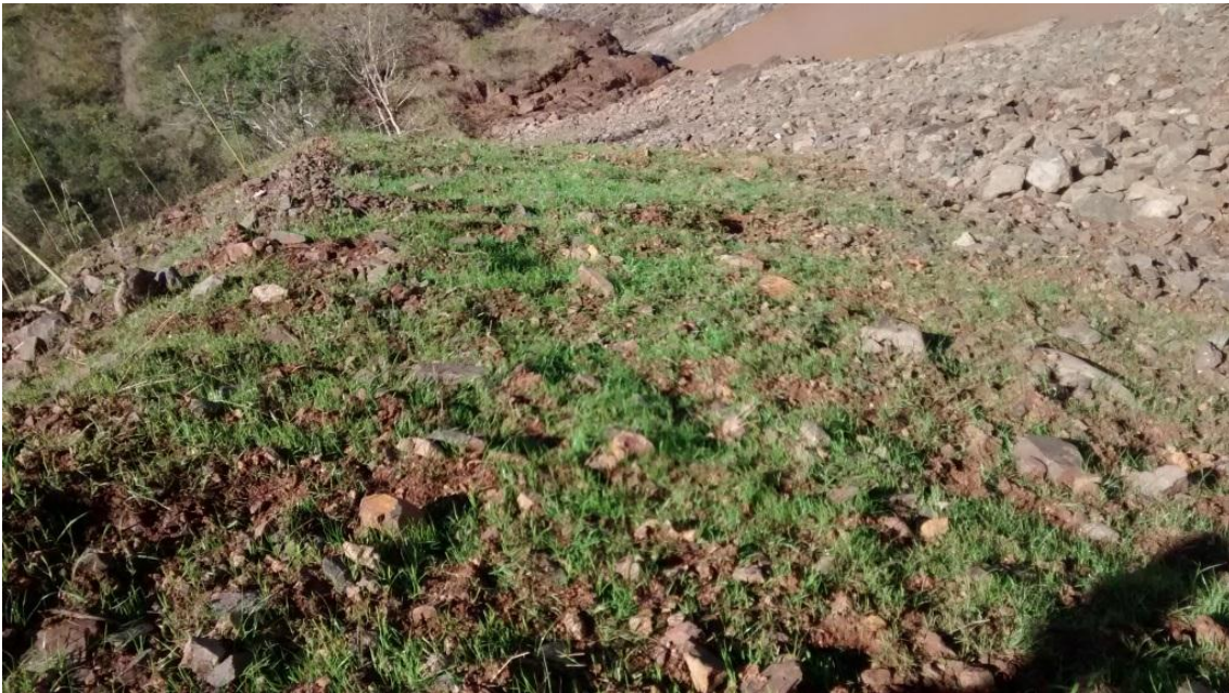
Recuperação do talude da margem direita após a semeadura do azevém e plantio das mudas.
