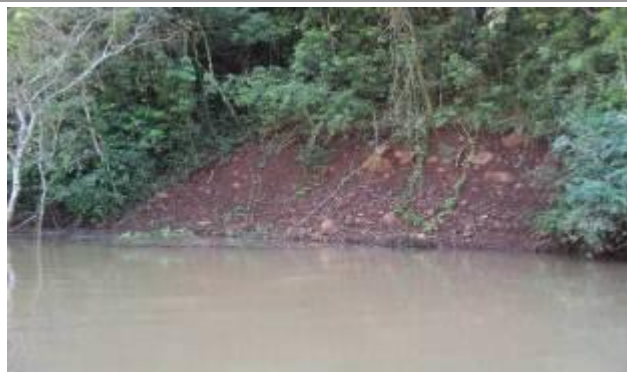
Foto 11: Situação inicial da instabilidade no Ponto 15
