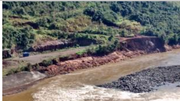
Vistoria realizada em 26/06/14
