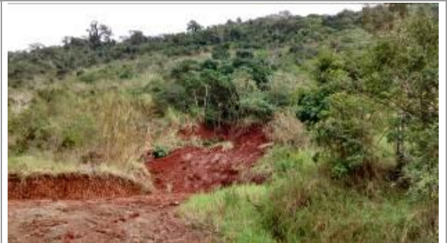
Vistoria realizada em 25/06/14
