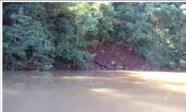
Vistoria realizada em 10/08/11.
