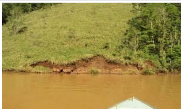
Vistoria realizada em 10/08/11.
