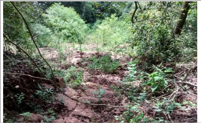
Vistoria realizada em 30/12/14
