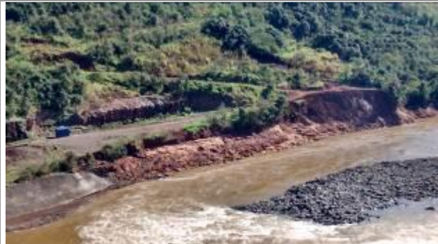
Vistoria realizada em 26/06/14
