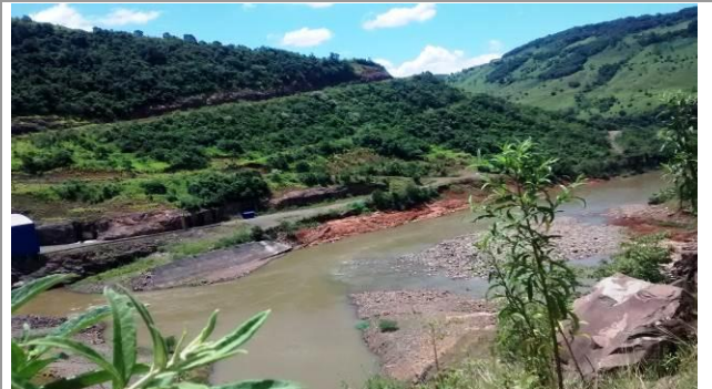
Vistoria realizada em 30/12/14
