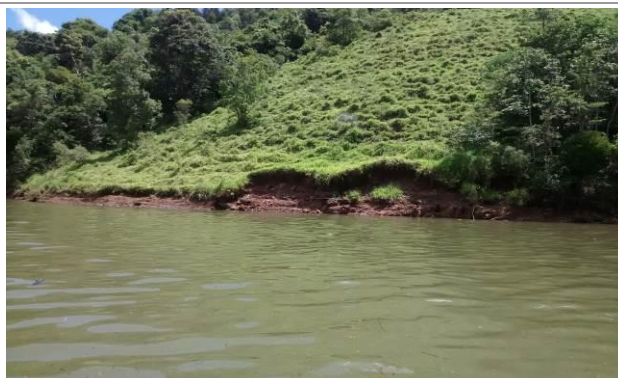
Vistoria realizada em 30/12/14
