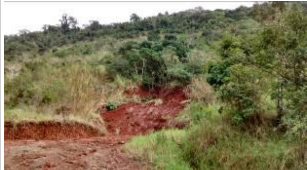
Vistoria realizada em 26/06/14
