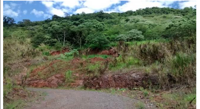
Vistoria realizada em 30/12/14
