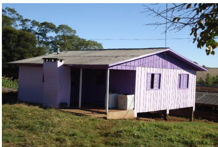
Figura 32: Foto da residência da propriedade reformada há pouco tempo.
