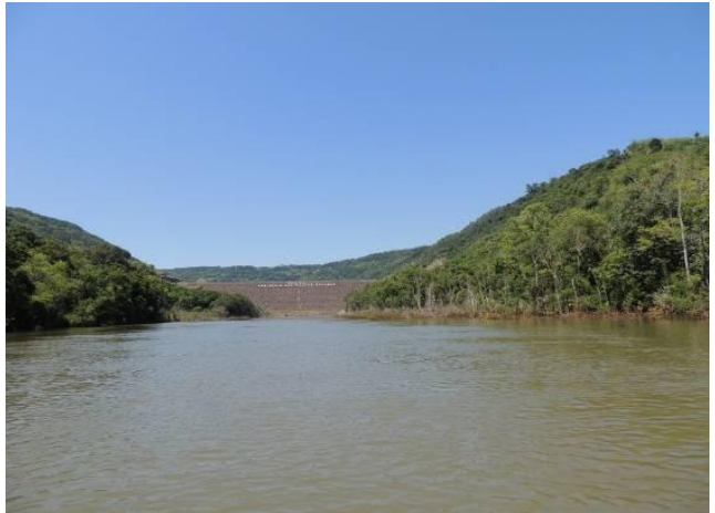
Busca ativa realizada com barco no PW 10, rio Passo Fundo – Jusante.
