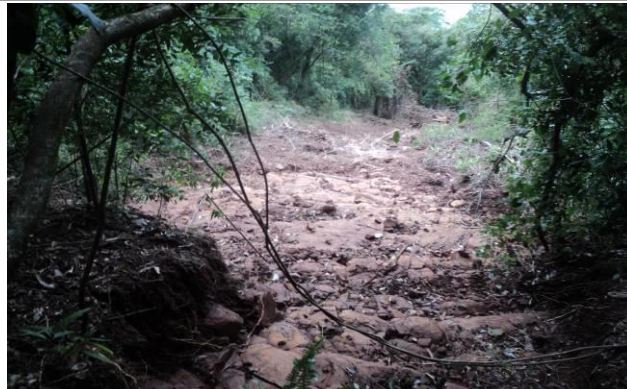
Foto 13: Situação inicial da instabilidade no Ponto 16
