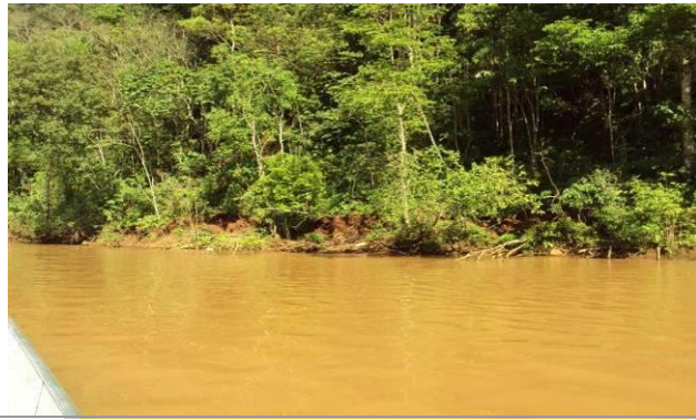
Foto 07: Situação inicial da instabilidade no Ponto 13
