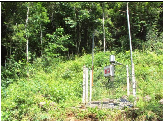
Foto 7: Vista geral da estação automática telemétrica Entre Rios Montante, em nov/13
