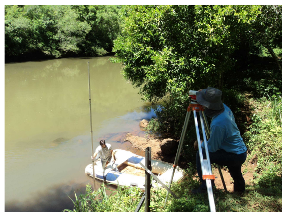
Foto 4: Conferência do nível do NA na estação Entre Rios Montante, em nov/13.
