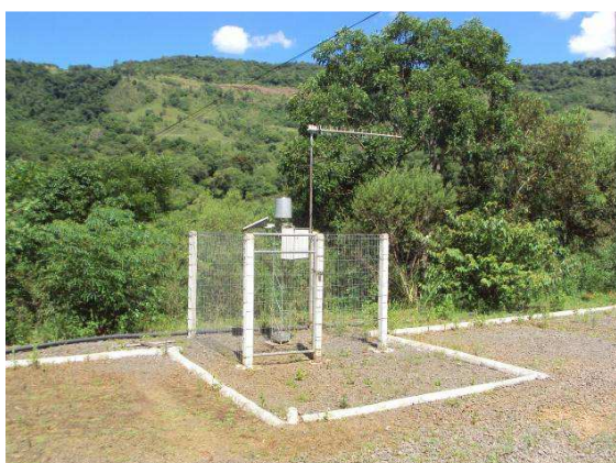
Foto 11: Vista geral da estação automática telemétrica UHE Monjolinho, em nov/13.
