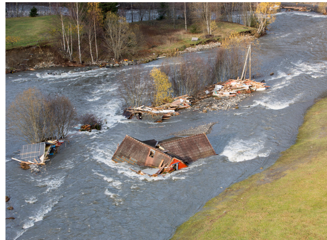
← A título de ilustração, durante a inundação na Noruega em outubro de 2014, Flâm e Odda registraram danos superiores a 50 milhões de euros, mas não houve danos comunicados nos cursos de água regulamentados nas vizinhas Aurland e Tyssedal.
