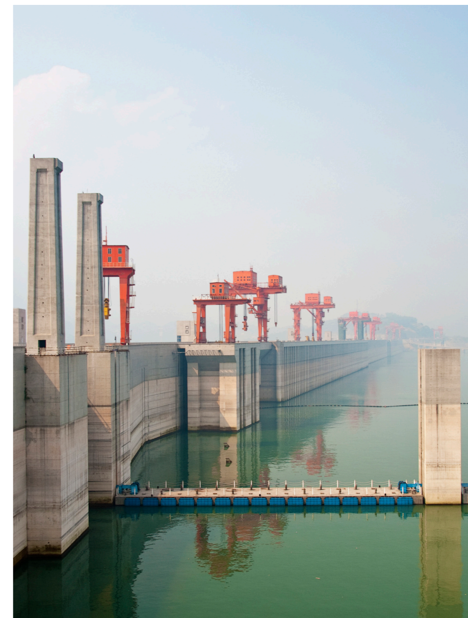
→ A Barragem das Três Gargantas na China pode conter um nível de água de até 175 metros, mas regula a água abaixo de 165 metros para proteger contra possíveis inundações. Em 2021, a barragem restringiu a vazão de água em 19.000 metros cúbicos por segundo, mais da metade da velocidade de afluência média no reservatório (de 40.000 metros cúbicos).
